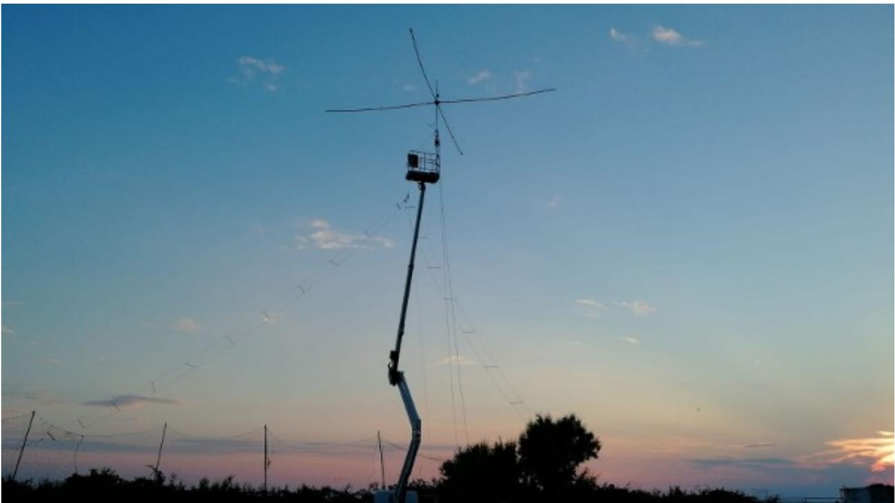
I cavi delle linee di trasmissione delle quattro antenne vengono fatti convergere su un commutatore esterno a controllo remoto 6x2, in modo da poterle avere tutte a disposizione sulle due stazioni impiegate (*runner* e *multi*), senza però il rischio di pericolose e letali (per le radio) condivisioni.
